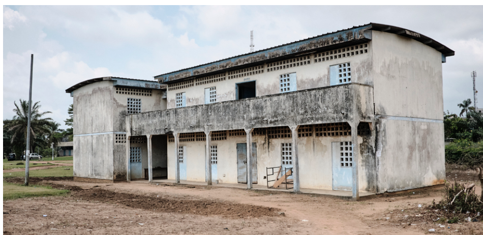
Figure 11. Vue extérieure d'un bâtiment de l'ETFP (Photo : Lavigne, 2018)
