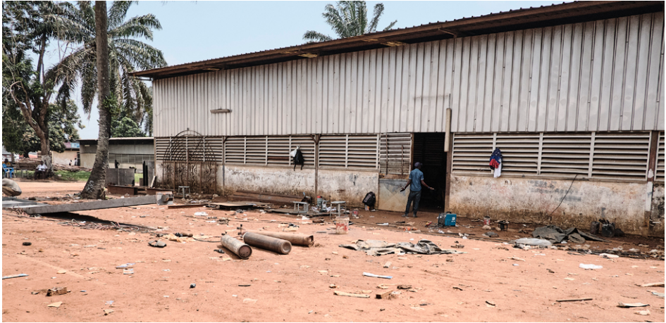
Figure 12. Vue extérieure d'un bâtiment de l'ETFP (Photo : Lavigne, 2018)
