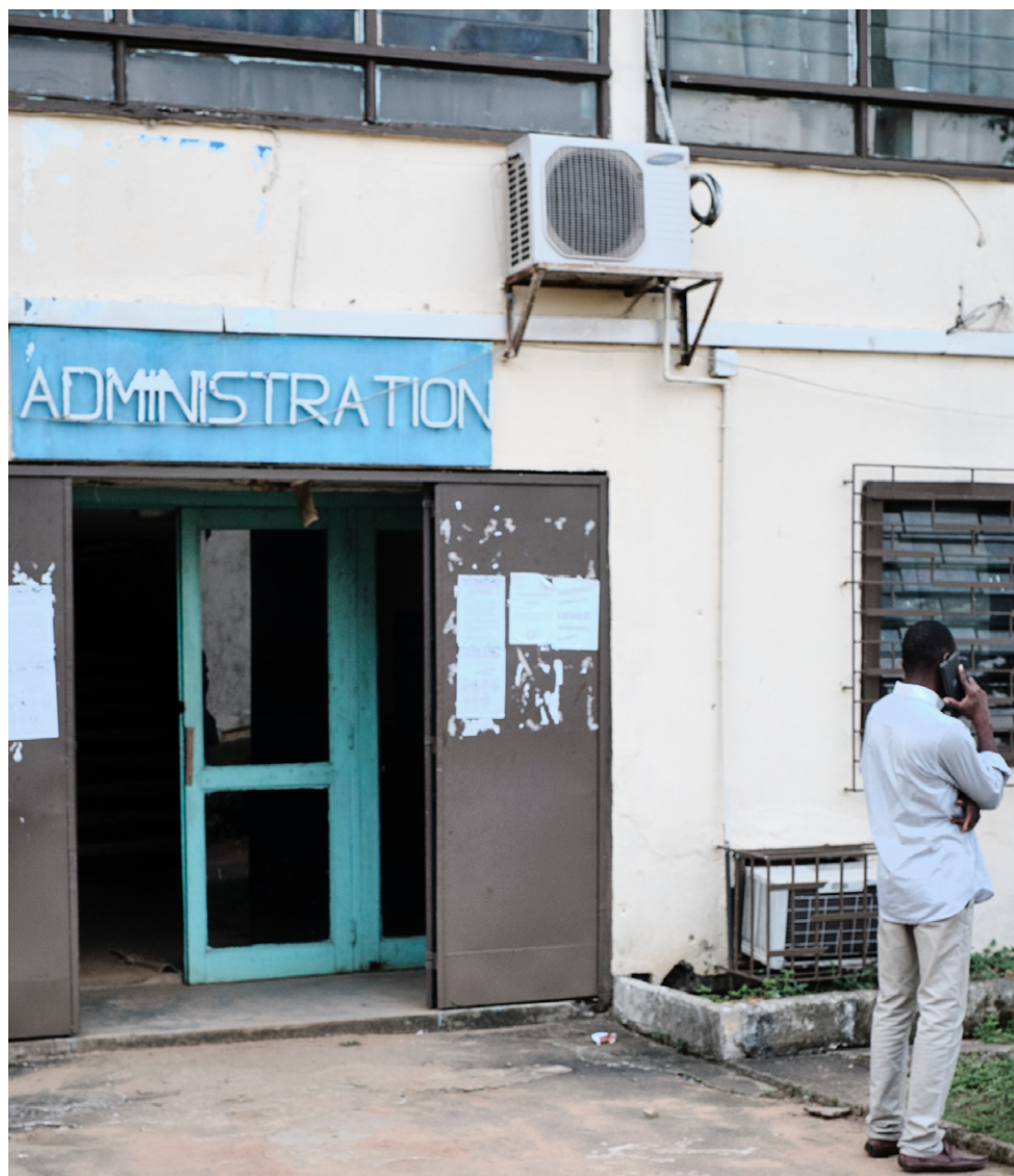
Figure 20. Entrée des locaux administratifs d'un établissement public de l'ETFP (Photo : Lavigne, 2018)
