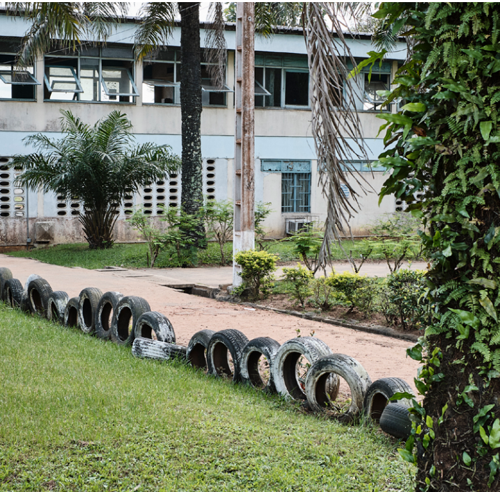
Figure 15. Vue extérieure d'un bâtiment de l'ETFP (Photo : Lavigne, 2018)
